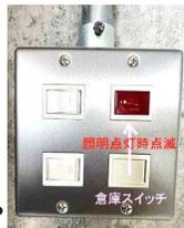
①夜間のセンター利用時に、玄関前照明の消し忘れがよくあったので人感センサー(夜間のみ自動点灯)を取り付けました。②地下ピロティー奥の倉庫の照明が点けばなしになっていることもあるため、照明スイッチの上に赤色 LED(点滅)を取り付けました。
